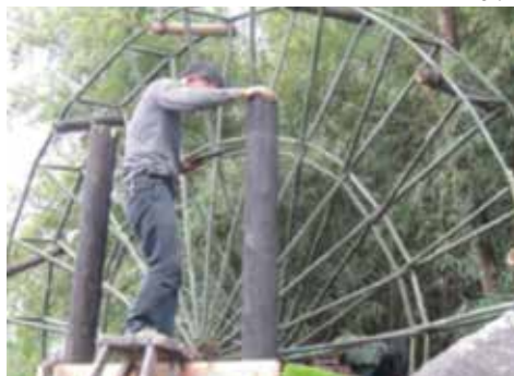
Montagem roda d'água Guilin Guangxi
